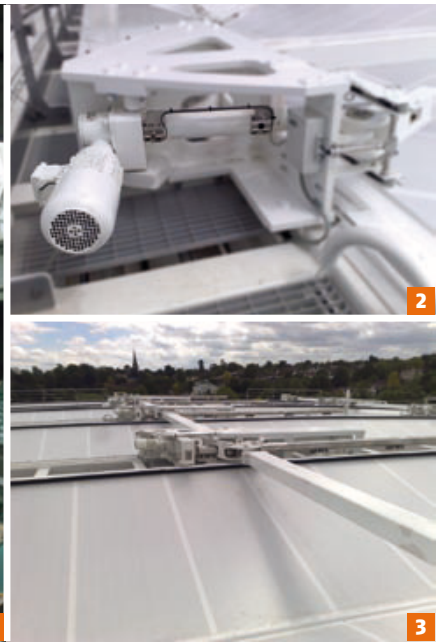
1 Der Wimbledon-Centre Court mit geschlossenem Dach 2 Ein Rolaram-Antrieb arretiert ein Dachsegment 3 Die neue Dachkonstruktion über dem Centre Court
